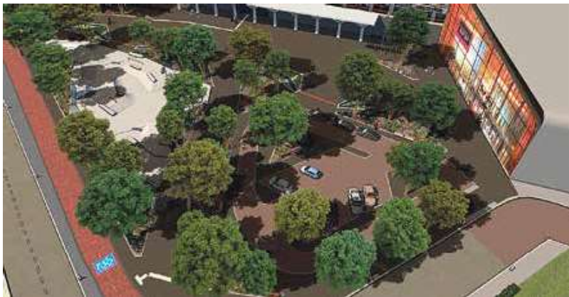
De transformatie van het Industrieplein vormt een belangrijke schakel in de gebiedsontwikkeling Hart van Zuid.
